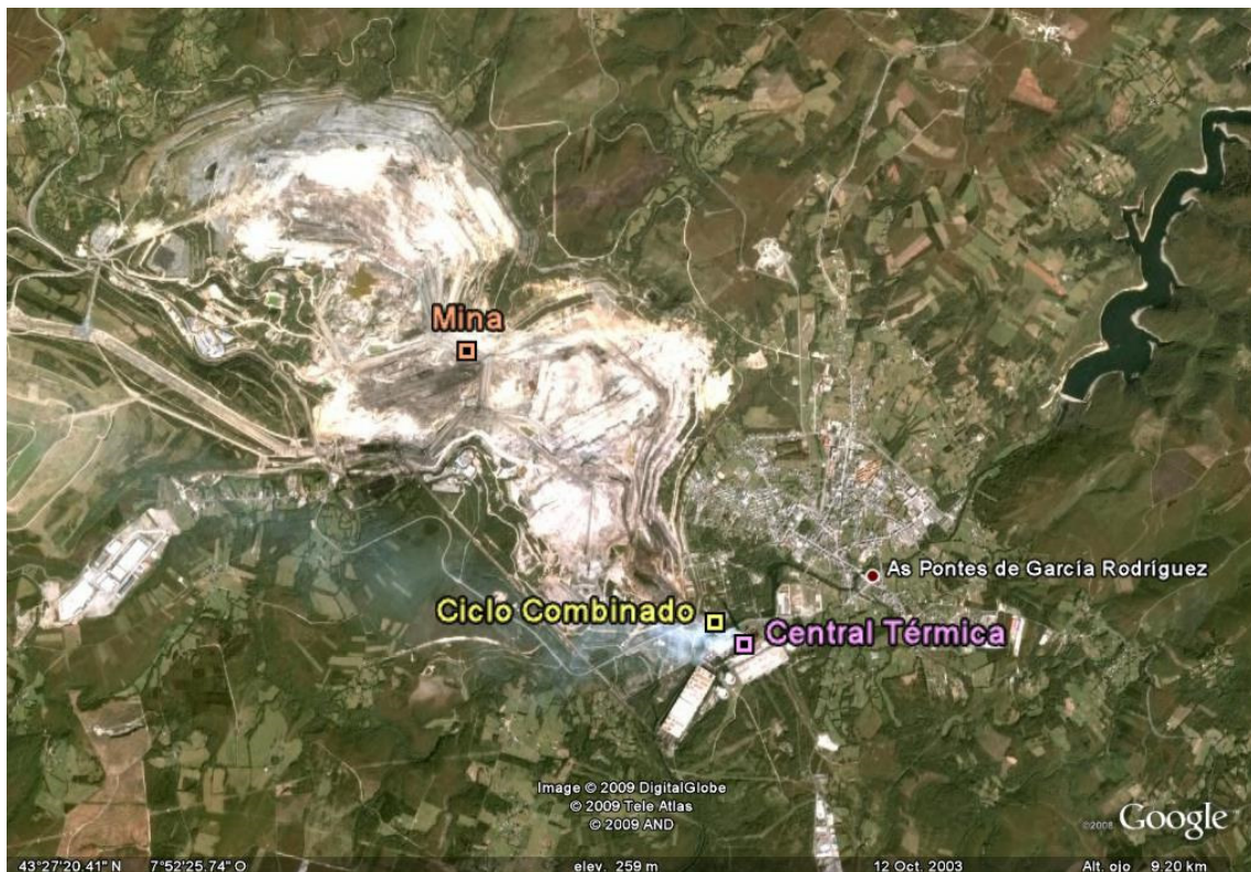
Figura 1.1 Situación de la U.P.T. de As Pontes.
