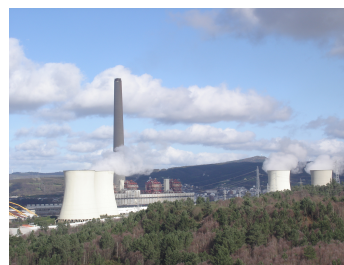
Figura 0.2: Chimenea de la central térmica de As Pontes. Extraída de Wikipedia-PepedoCouto (2009) .
